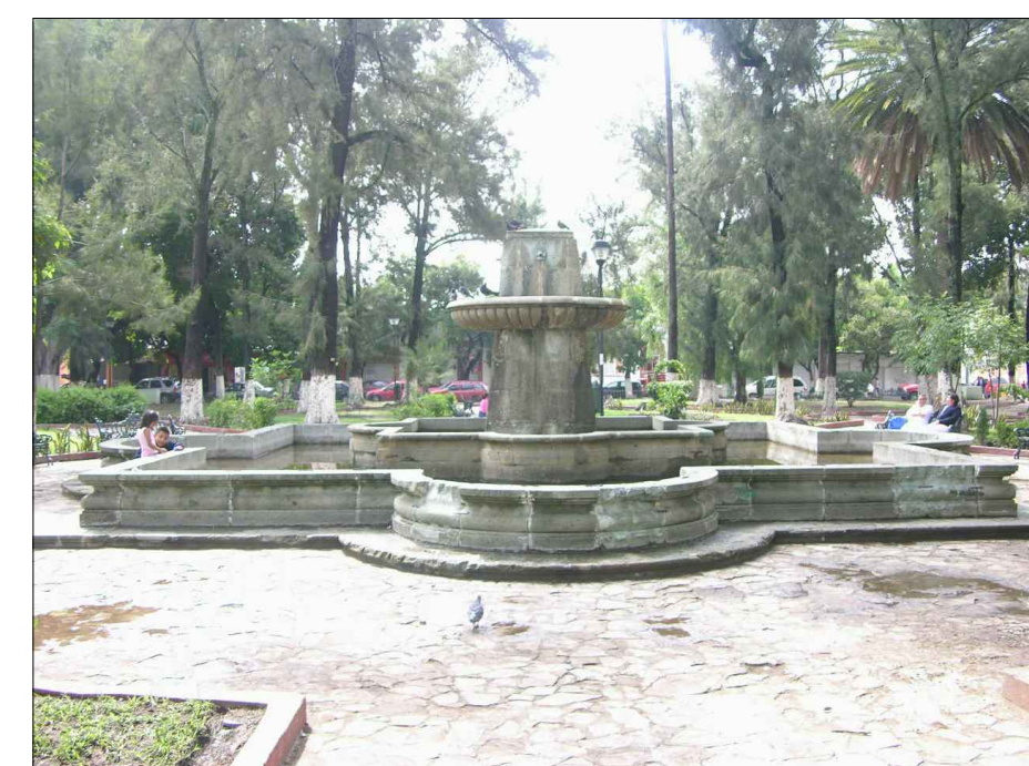
FUENTE A BASE DE SILLARES DE CANTERIA VERDE LABRADA, JUNTEADA Y ASENTADA CON MORTERO CEMENTO- ARENA
