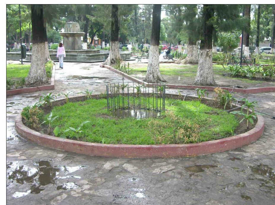
GUARNICION A BASE DE CONCRETO, ACABADO COMUN Y PINTADA EN COLOR ROJO.
